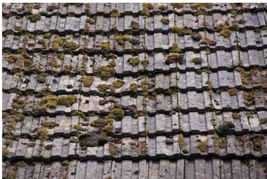
Figuur 12: Dakvlak gedekt met cement muldenpannen. De worden op den duur poreus, wat de levensduur beperkt.
