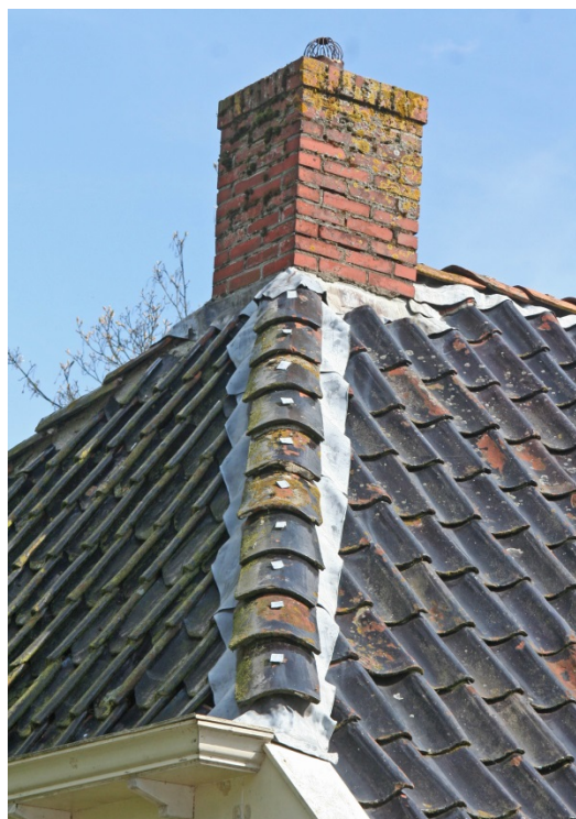
Figuur 7: Karakteristieke afwerking van nokken en kepers in Noord-Nederland met loodstroken onder de vorst- en keperpannen.
