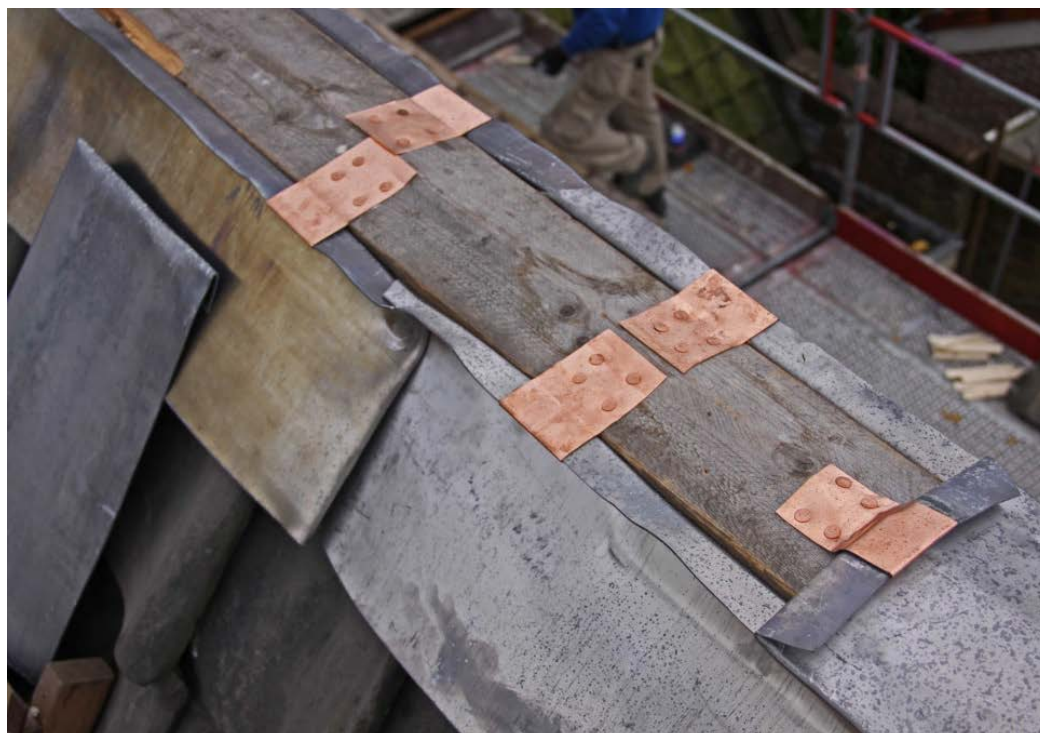
Figuur 8: Noklood aangebracht in 3 delen van 25 kg/m 2 , vastgezet met koperen klangen. De delen zijn in lengtes van 1,0 meter verschervend aan elkaar gefelst.
